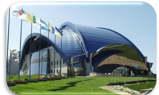
Dach Sportpalast Odessa
